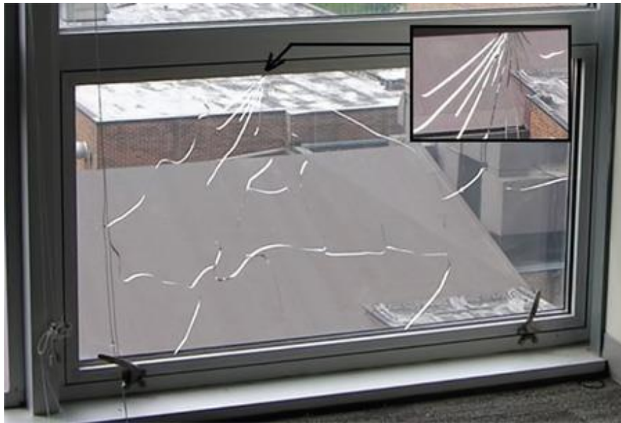
Малюнок 1 – Руйнування скла від термошока
