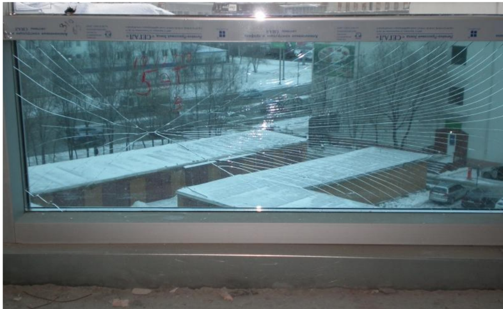
Малюнок 3 Приклад руйнування скла в пакеті із-за перепаду тиску і температури
