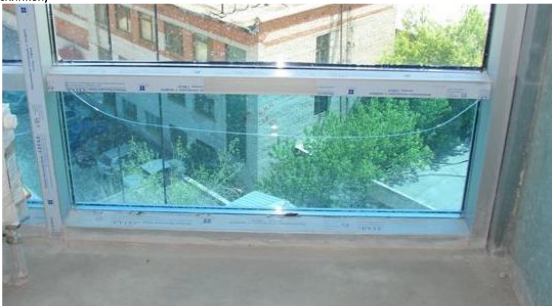
Рис. 5. Пример разрушения стекла в пакете из-за перепада давления и температуры
