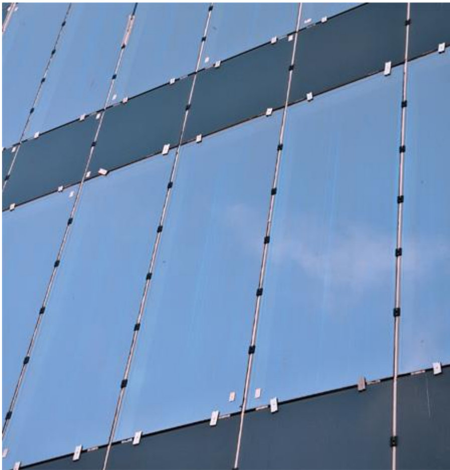
Рис. 9 Вертикальные полосы на стеклопакете
